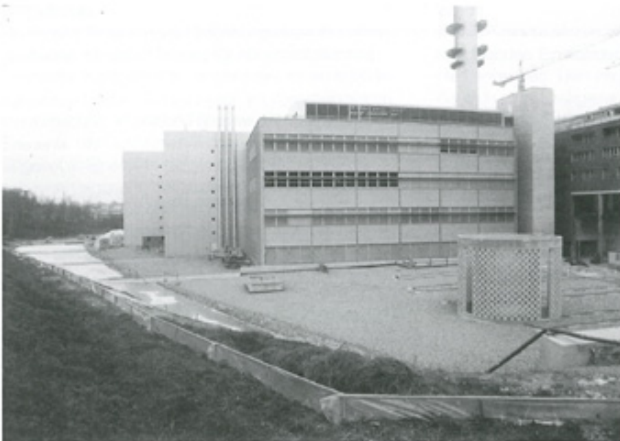
Das neue Fernmelde- gebäude, links die Verdunstungsbecken
