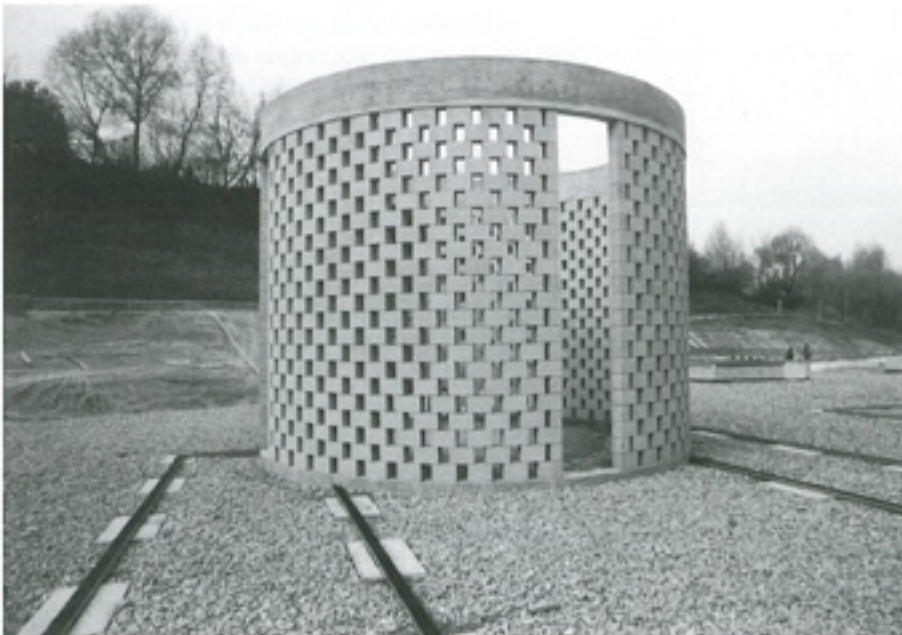
Detail: Pavillon, im Hintergrund die noch leeren Wasserbecken
